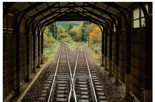
スイッチバック 3 段目（左）と 2 段目（右）の折り返し地点。積雪からポイントを守るために屋根が設置されている。
