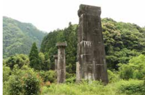
立ち続ける橋脚群（下府川橋梁） 円形の橋脚は流水の影響を小さくするためである。
