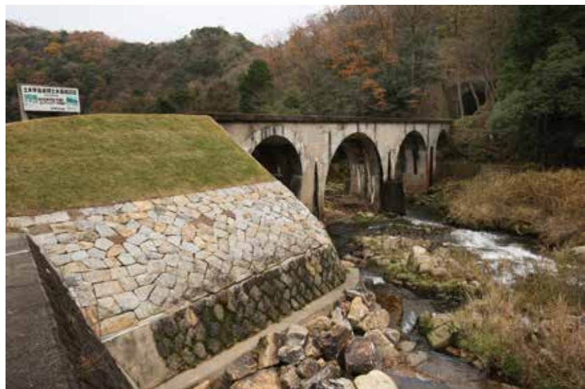
立ち続ける橋脚群（下府川橋梁） 円形の橋脚は流水の影響を小さくするためである。
