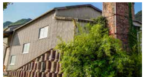
備前土管を窯の土台に用いている
