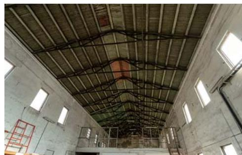
建物は幅12m、奥行き32mで、正面入口側は2階建て、屋根裏の骨組みは鉄骨造り。
